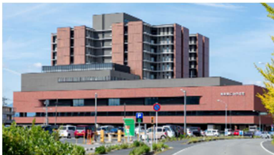
新病院の全景
